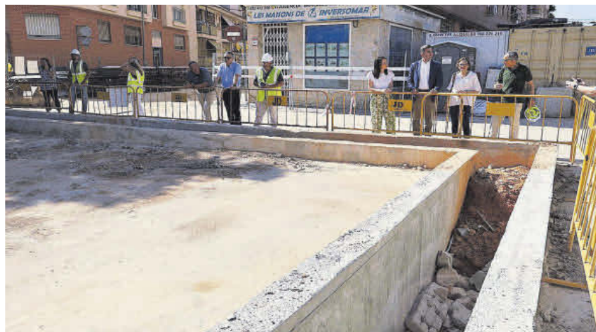
Obras de ampliación de la capacidad del colector de la EDAR de San Pedro.
